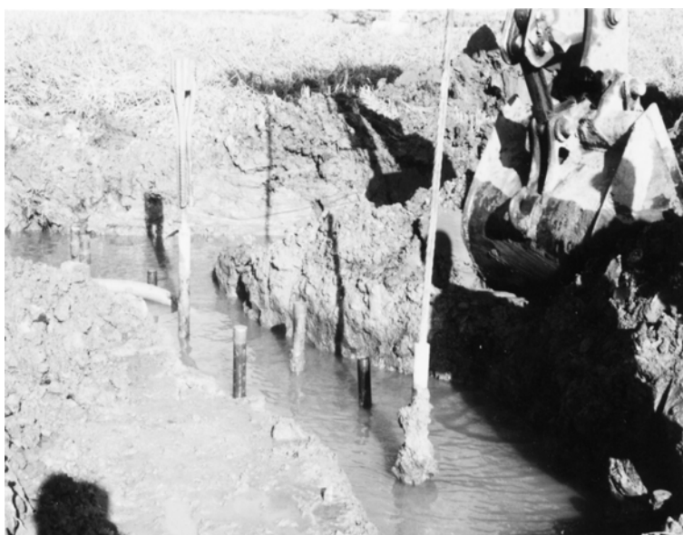
شکل ۳: میکروپایل‌های اجرا شده در شالیزارهای شمال ایران (رشت)
